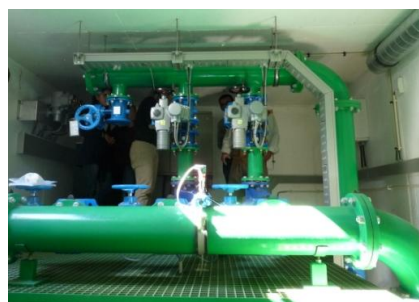
Figura 3. – Vista do bypass no interior da câmara de válvulas.
