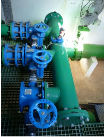
Figura 4. Vista das turbinas no interior da câmara de válvulas.
